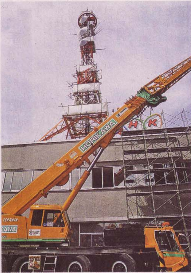
きょう3日から解体が始まるNHK秋田放送局旧会館の鉄塔
